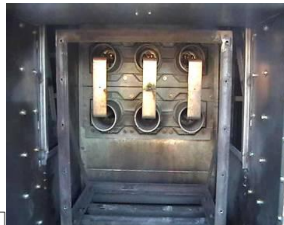
40kA , 12kV 60ms celkový vypínací čas
